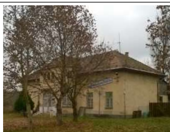
Billei kastély a 31.sz főút nyugati szakaszán
